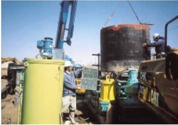
仮設ケーシング据付
