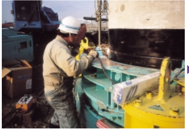
側塊溶接状況
