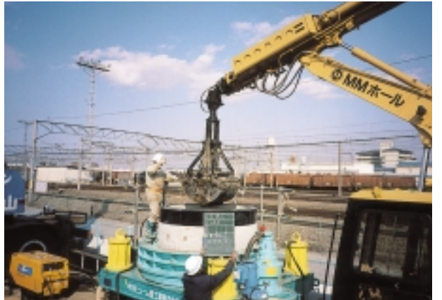
掘削、圧入状況
