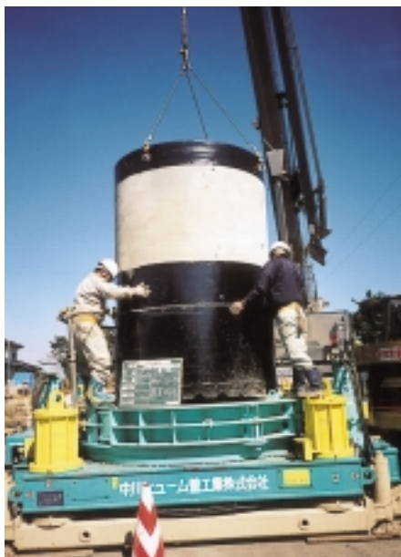
刃口、側塊設置
